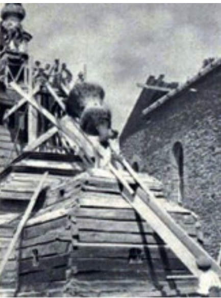
Спуск вежі. Всі елементи ретельно позначили. Фото з часопису Pestrý Tyden, 1929.
