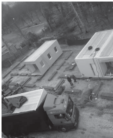
Під час будівництва чеських будиночків для переселенців на Київщині.
